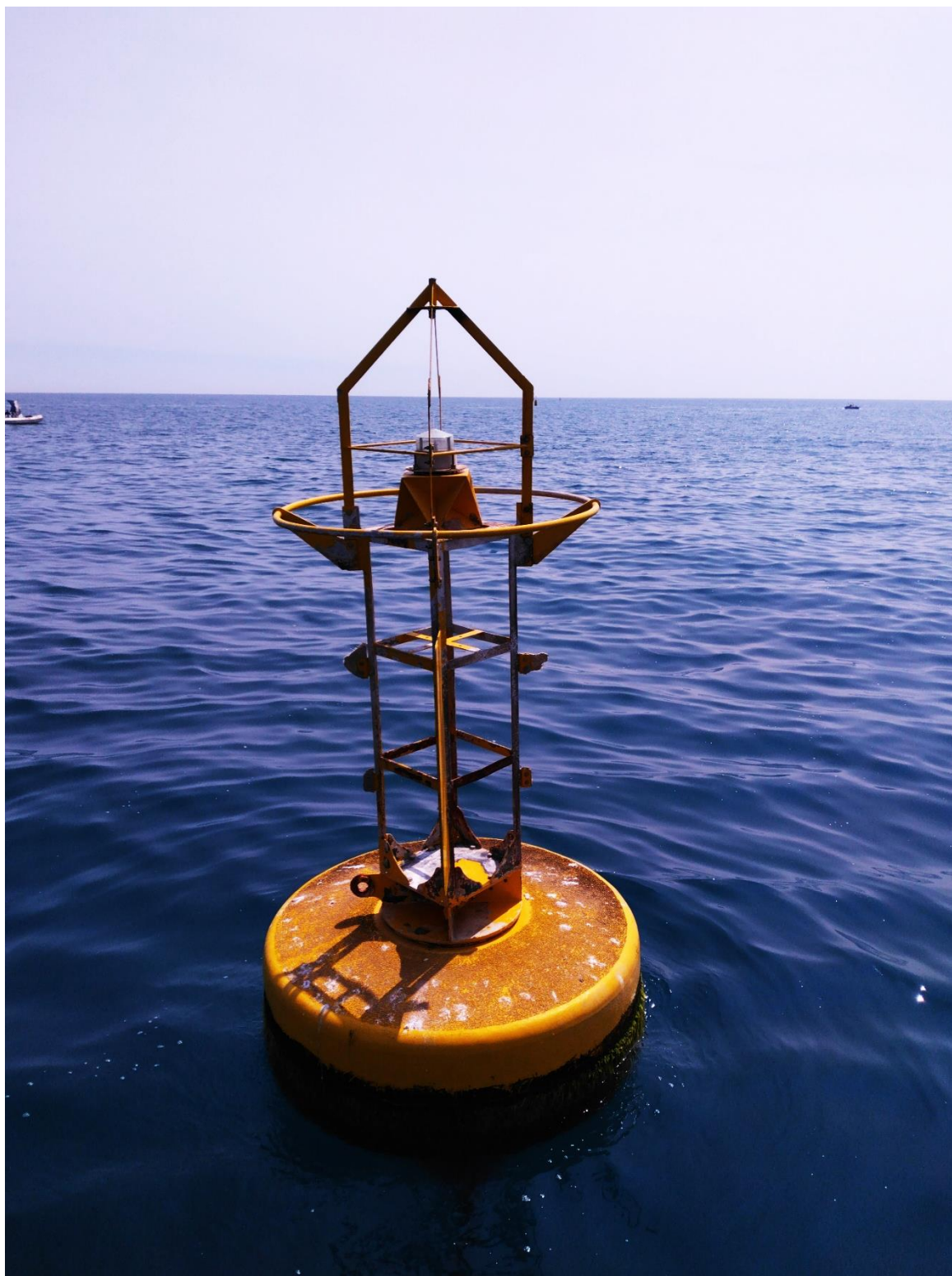
Figure 2 – Balise Côte Ouest (panneaux et croix cassés / absents) © P2A Développement, 2024
