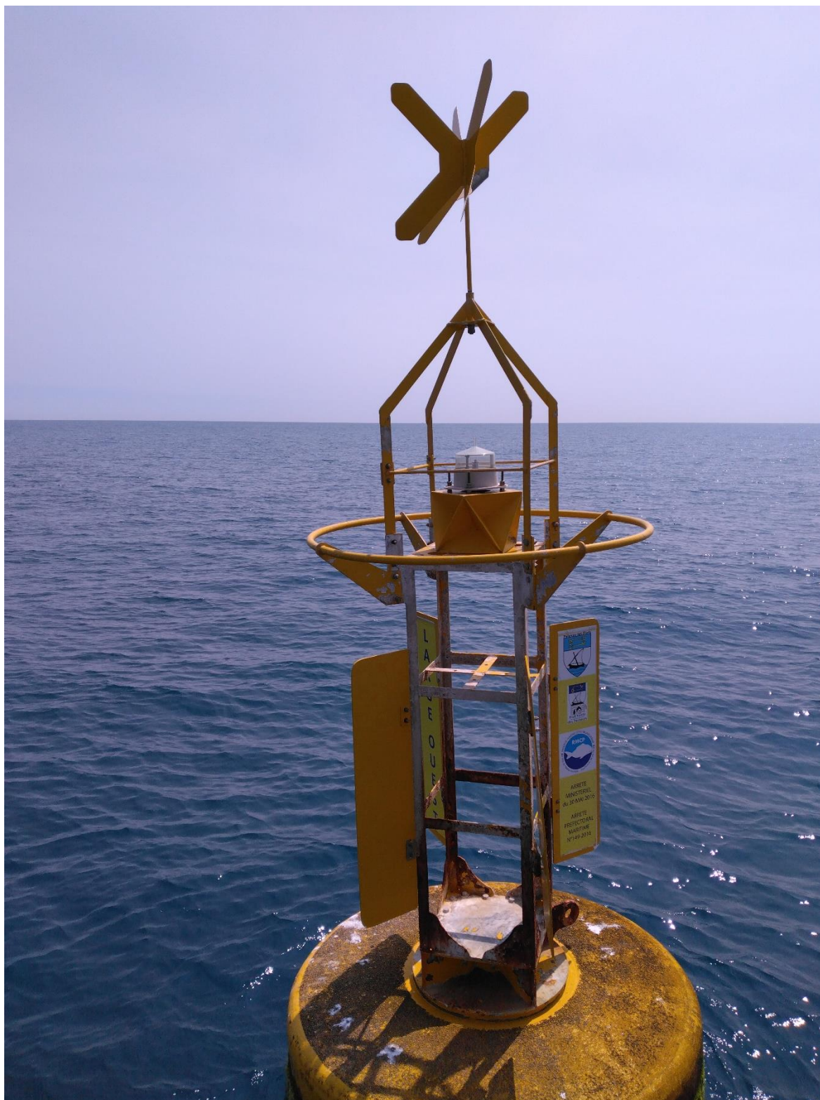
Figure 7 - Balise Large Ouest (panneaux et croix endommagés) © P2A Développement, 2024
