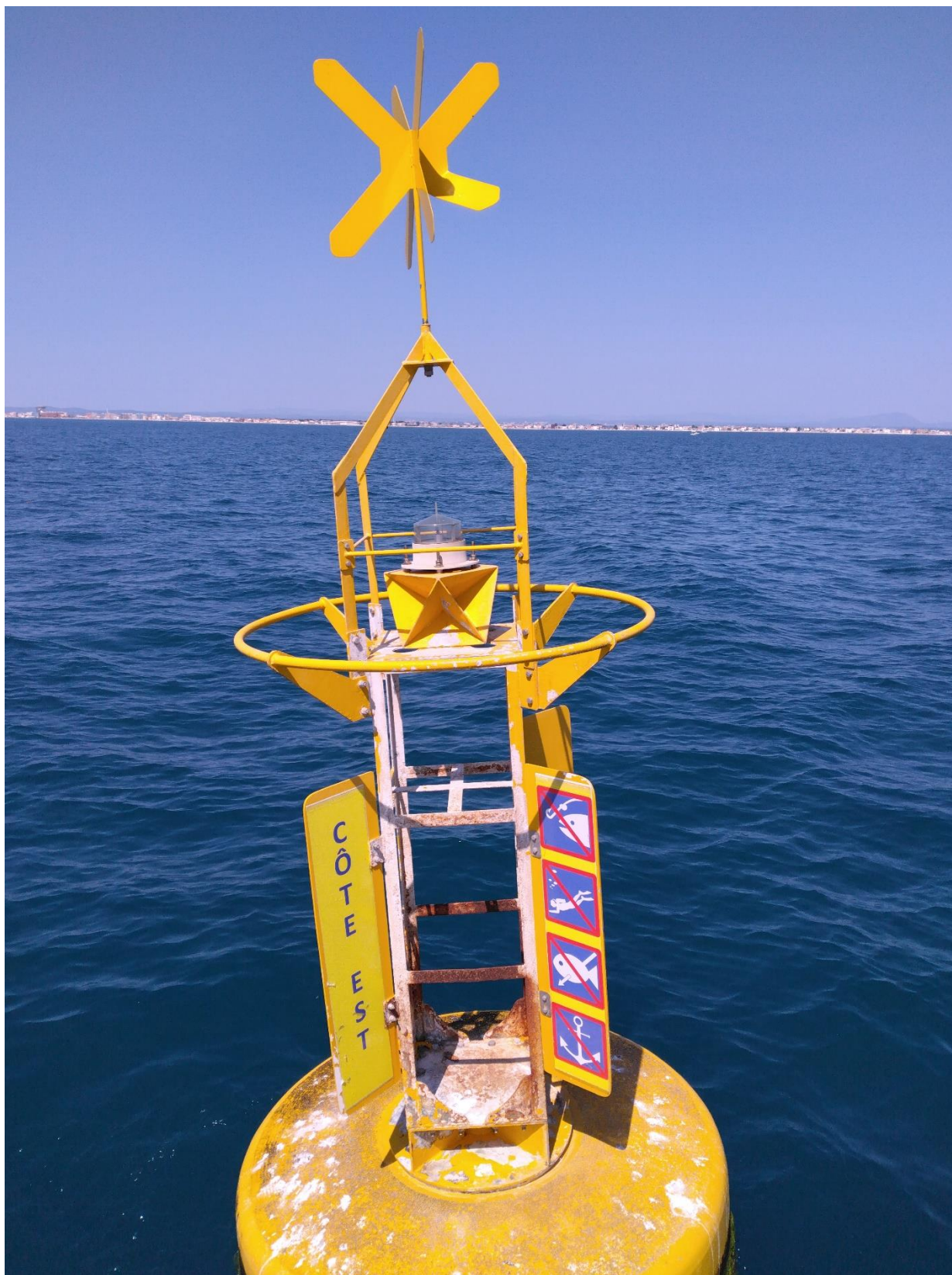
Figure 13 - Balise Côte Est (panneau cassé / absent) © P2A Développement, 2024
